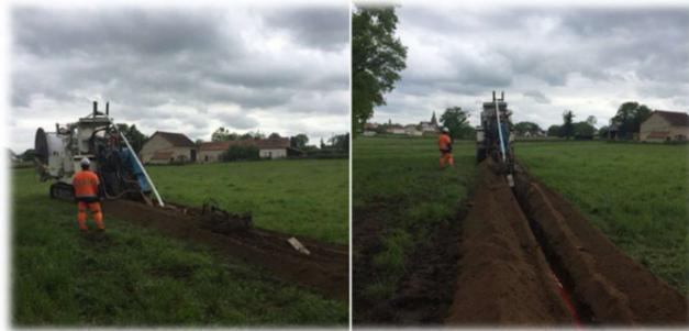
Figure 134 : Exemple de chantier d'enfouissement d'un réseau électrique en terres agricoles (source : Cegelec infra)
